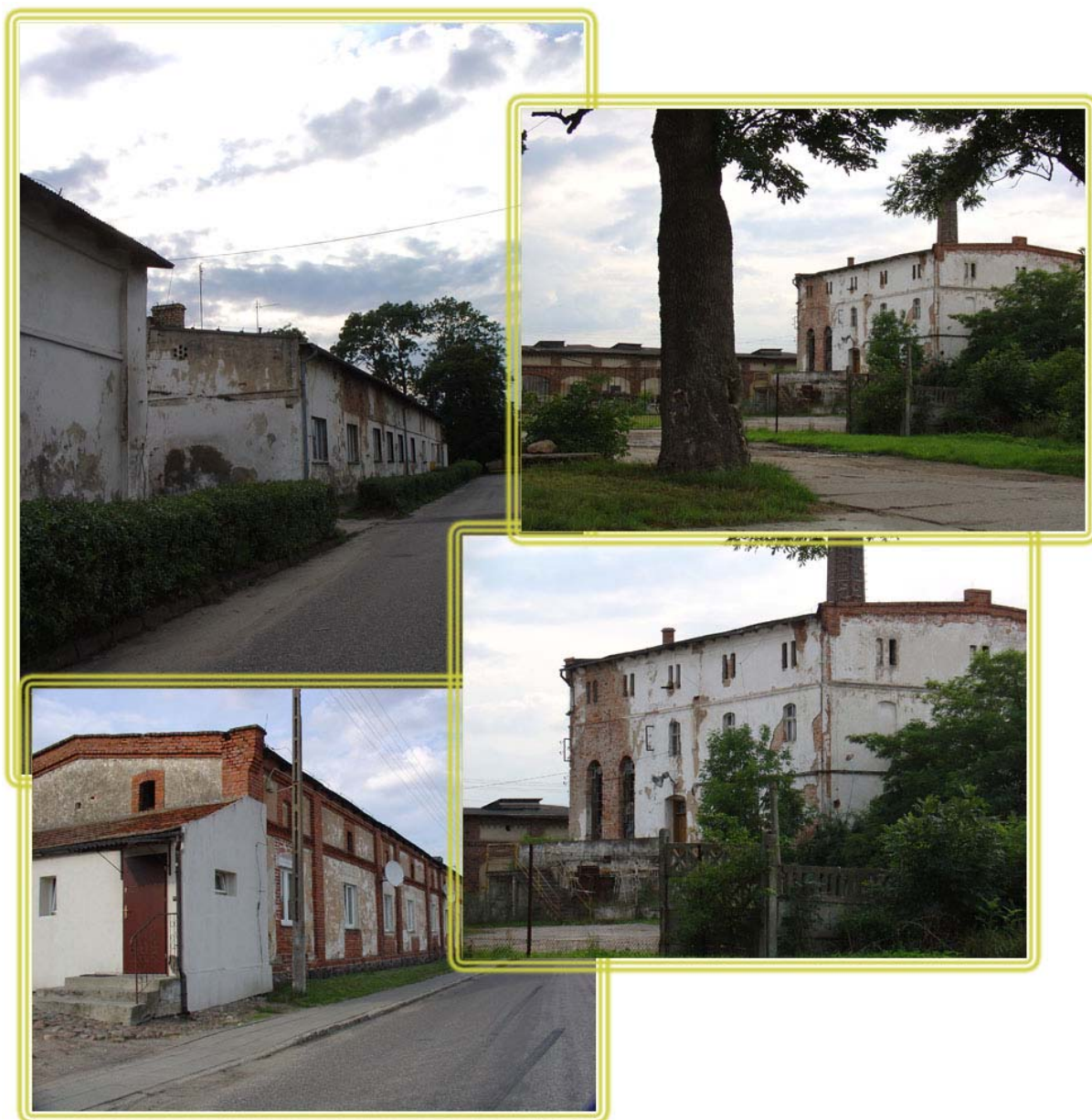
Fot. 7 Popegeerowskie budynki w miejscowości Krzyżanowo, w której mieści się fabryka firmy Sunset Suits. Autor: Jan Poleszczuk
